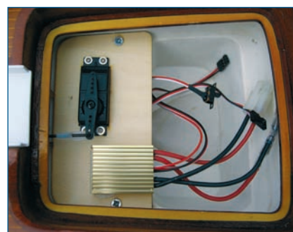
Les câblages moteur, variateur et servo de direction.
